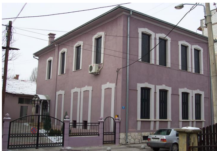
Slika 40. Zgrada Jehovinih svedoka u Nišu (decembar 2008)
